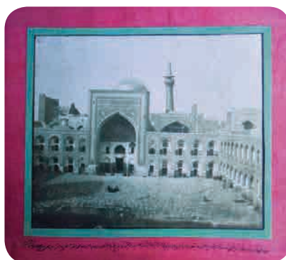
تصویر ۴: صورت صحن نو، با شرحی درباره معرفی بنا، عکاس جیانوزی، شماره ۳۸۴/۳۰۴ آلبوم خانه کاخ گلستان.
