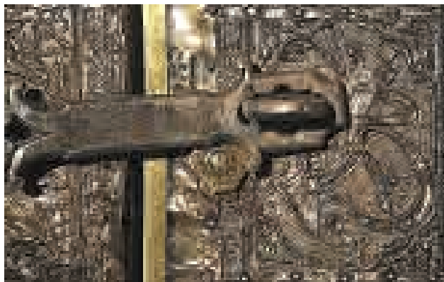
تصویر شماره (۲۲) چفت و بست نصب شده در مرکز درب
