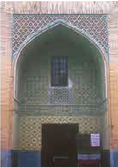
شکل ۹- نمای داخلی ایوان ورودی، مدرسه دودر (حاجی قاسمی، ۱۳۷۹: ۲۳۱)
