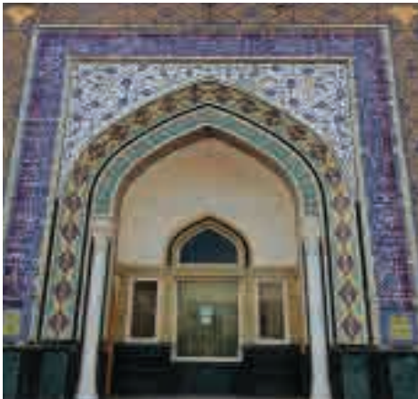
تصویر ۱۰: لچکی کاشی معرق زمینه نرمد، صحن جامع رضوی، معاصر، (تصویر از نگارنده)
