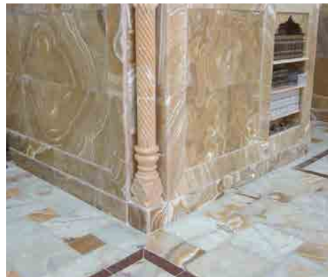
تصویر ۵۵: حاصل مرمت و اجرای طرح
