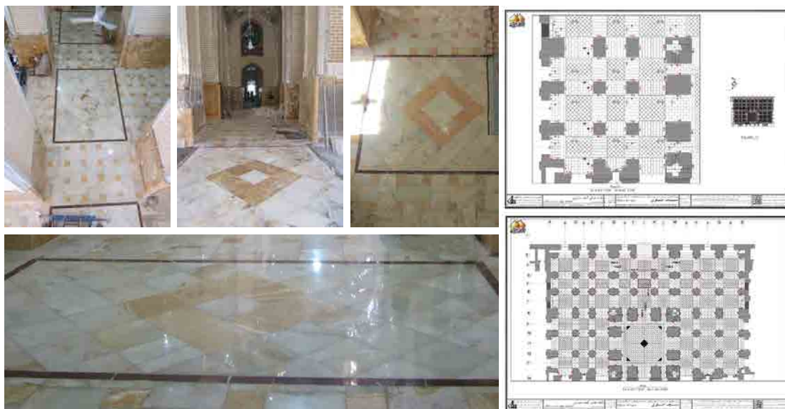
تصویر ۴۶: طرح و اجرای کفسازی
